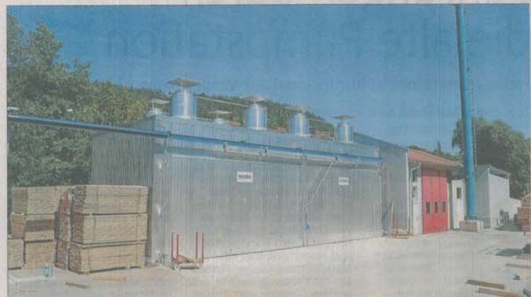
Die neue Holz Trocknungsanlage (links) der Firma Kübler mit angeschlossener Heizzentrale (rechts). Foto: Katzmaier
